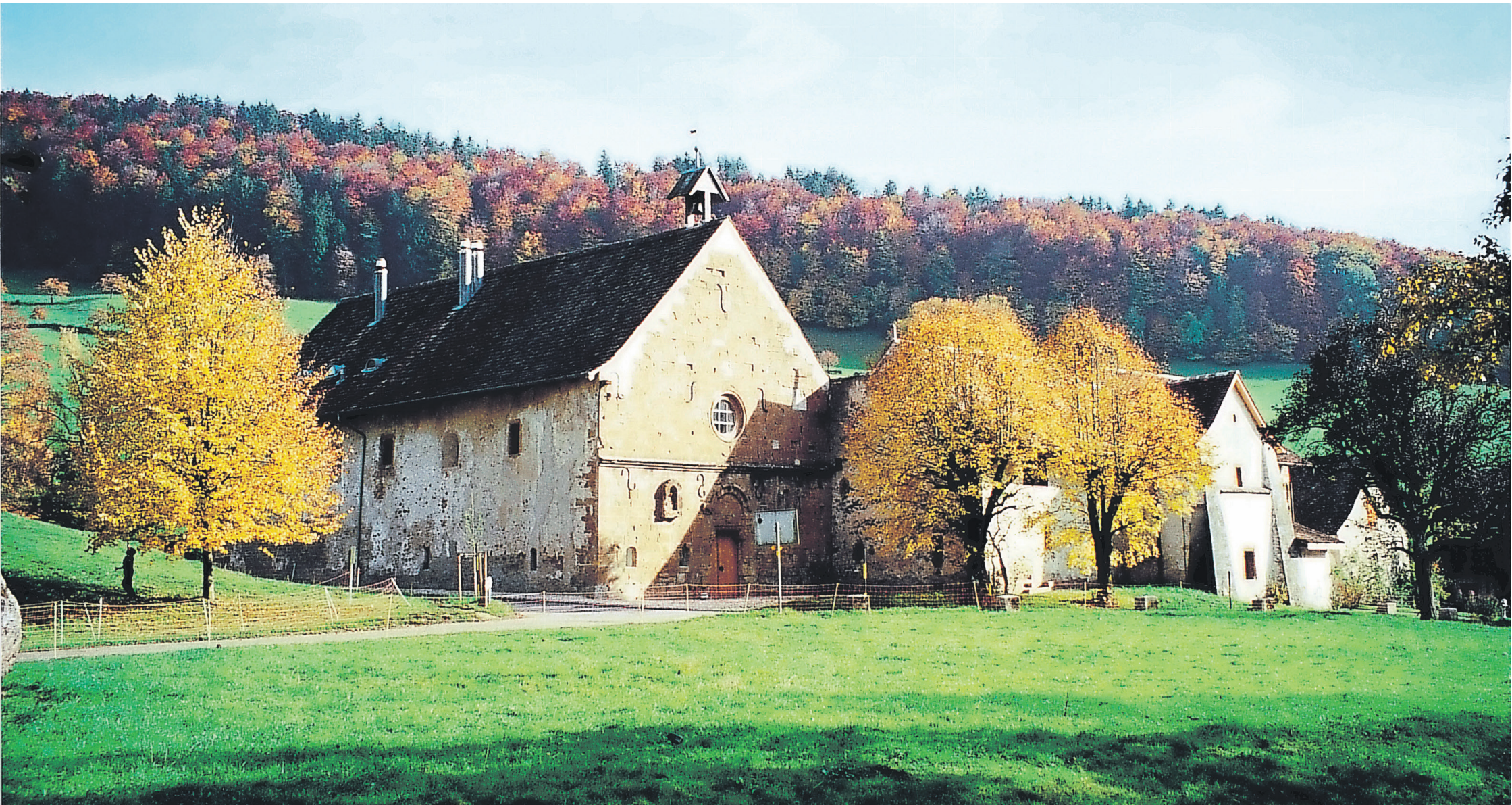
Aus einer anderen Zeit und fernab von der Zivilisation: Das ehemalige Benediktinerkloster Schönthal zählt zu den Baselpieter Kulturdenkmälern, steht unter Denkmalschutz und ist heute ein kultureller Begegnungsort. BILDER HEINER GRIEDER
